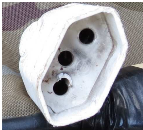
Tomada danificada por superaquecimento (mau contato)
