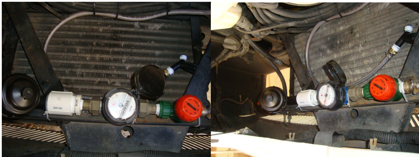
Entrada de água com filtro (preto), hidrômetro e temporizador (laranja)
